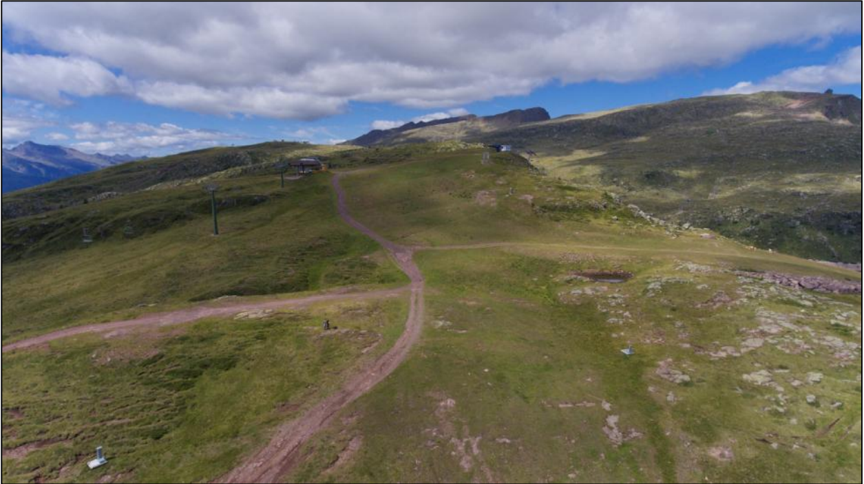
Vista della parte sommitale del tracciato dove sono previsti i movimenti terra di scavo e riporto più consistenti
