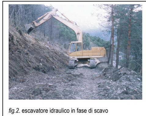
fig.2. escavatore idraulico in fase di scavo
