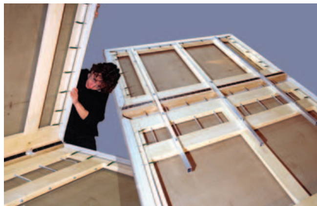
Figura 2 – Il movimento di apertura e chiusura del telaio. È visibile la struttura di rinforzo per il telaio aperto.
