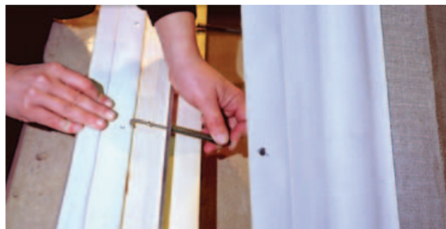
Figura 3 – L'aggancio della tela al telaio tramite il pistoncino che collega la barra piatta inserita nell'asola alla lama fissata sul telaio.
