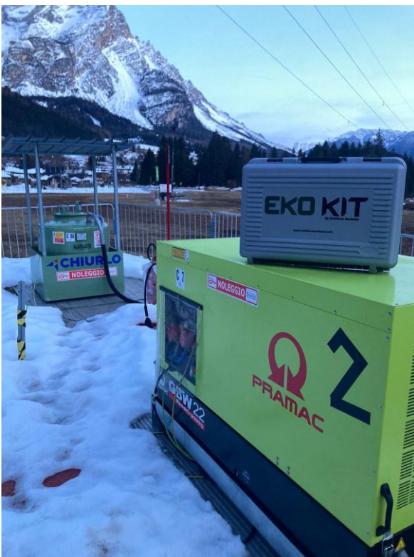
generatore posizionato su strato in alluminio
